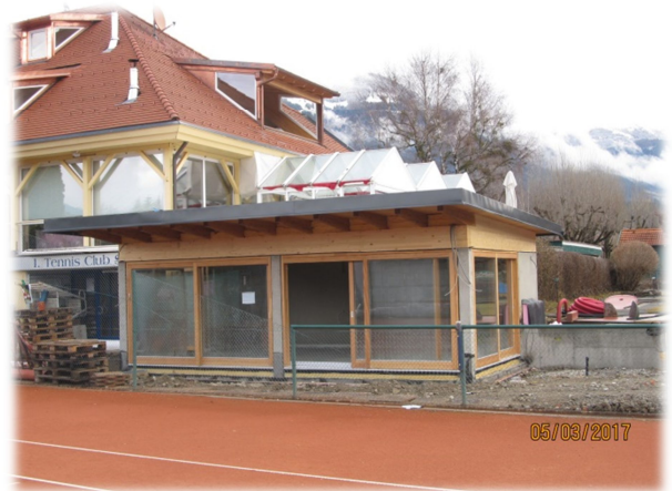
Clubraum in der Bauphase Anfang März
